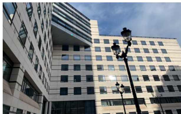
Immeuble Diamant - entrée A
